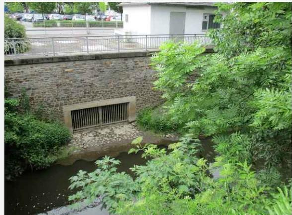
Abb. 74: Einlaufbauwerk in der Nähe der Einmündung des Wetzbaches in den Mühlgraben.
