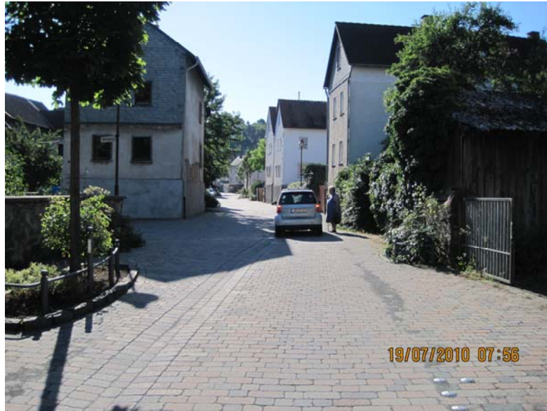
Vorhandener Ausbau der „Bachstraße“
