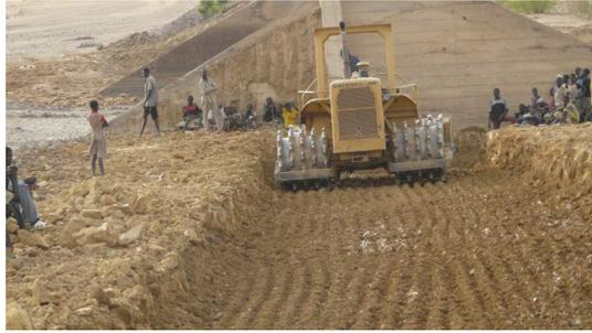
Eine Baufirma macht die Erdarbeiten und zum Schluss werden die Steine auf die Böschung gelegt
