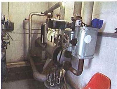
**Bild 36:** Rohrbündelwärmetauscher
