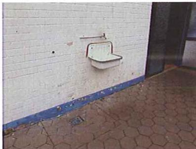
**Bild 41:** Aufsteigende Feuchte im Sockelbereich
