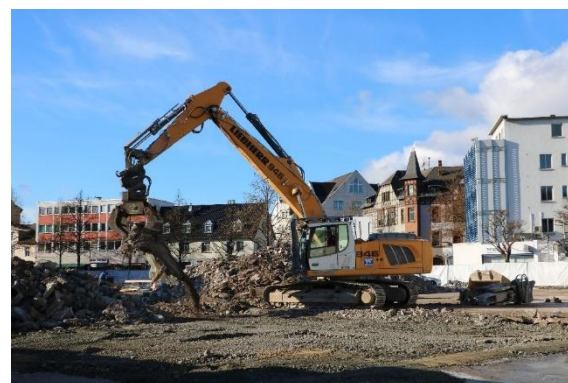
Abriss des leerstehenden Lahnhoofs in Wetzlar für den Neubau von Wohnungen
