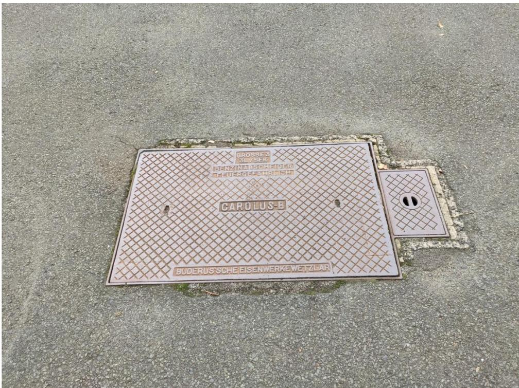
Foto 4: Leichtflüssigkeitsabscheider (LFA) vor Gebäude IV
