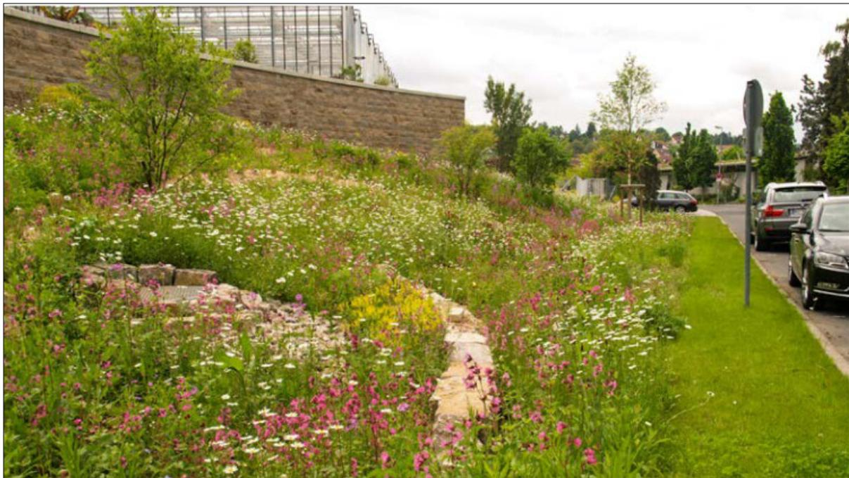
**Abb. 22:** Beispiel einer naturnah gestalteten Versickerungsmulde. Quelle: Bayr. Landesanstalt für Weinbau und Gartenbau (2019): Pflanzen für Versickerung und Retention. Sonderdruck aus Veitshöchheimer Berichte 186, 2019, S. 73-85
