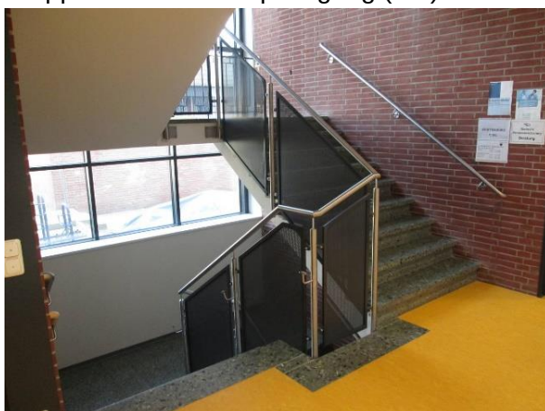
Treppenhaus bei Haupteingang (EG)
