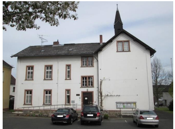
Ansicht vom Parkplatz
