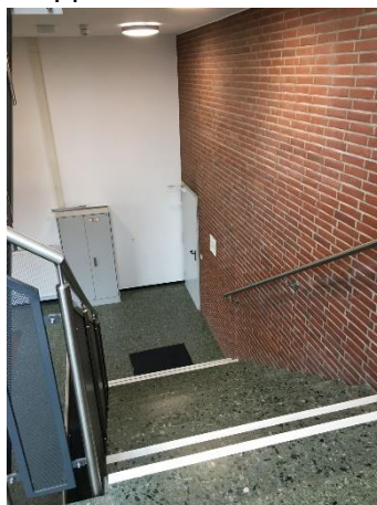
Treppenhaus bei Saal
