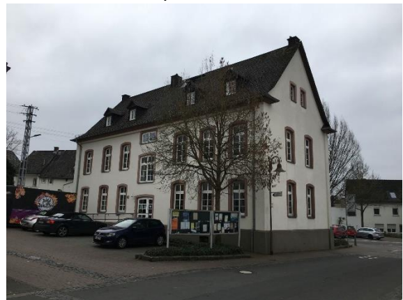
Ansicht vom Parkplatz
