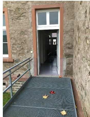
Hintereingang auf Gebäuderückseite
