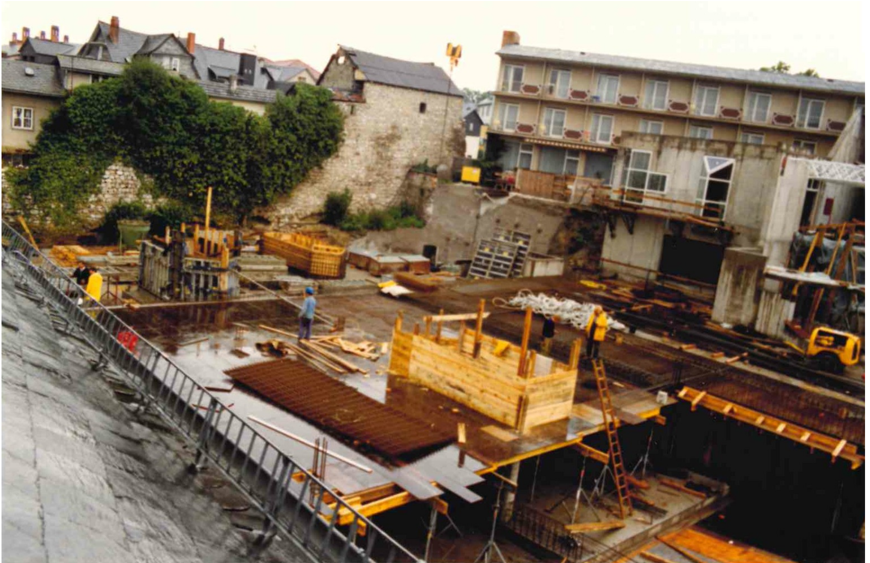
Bild 4 – Geschossdecke über Ebene 3, im Hintergrund Schwergewichtsmauer zur Hotelterrasse
