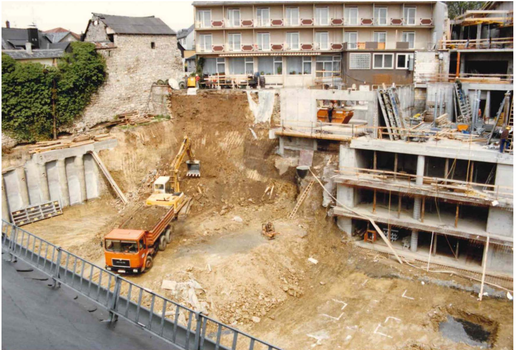
Bild 1 – rechts Vorbetonierte Wände und Decken der Stadthalle, Gründungssohle Ebene 5, links Baugrubenaushub und Baugrubenverbau zur Stadtmauer Gründungssohle Ebene 4
