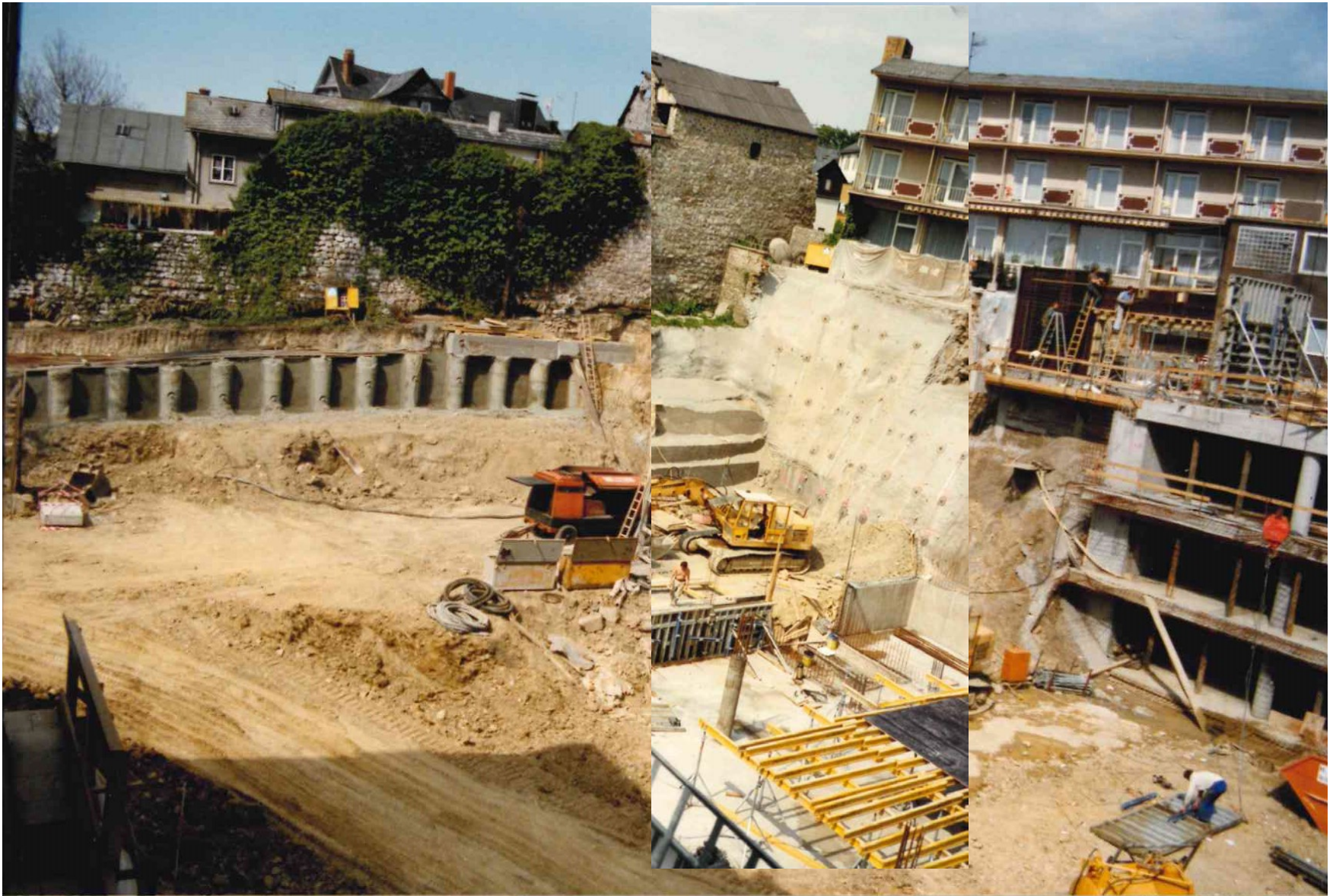
Bild 2 – Baugrubenverbau mit Betonbohrpfählen und Spritzbetonausfachung zur Stadtmauer (Norden), Gründung Schwergewichtsmauer
