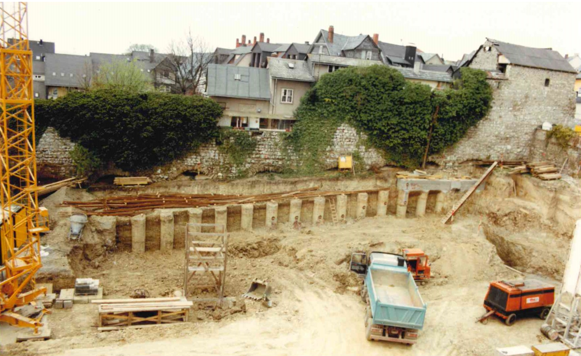
Bild 3 – Baugrubenverbau mit Betonbohrpfählen und Spritzbetonausfachung zur Stadtmauer (Norden)
